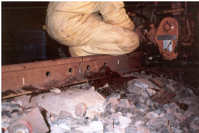
Figura 4 – Operação de furação do carril.
