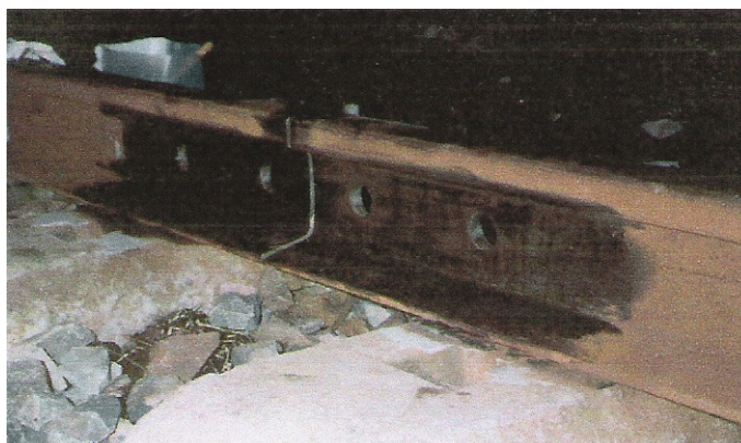
Figura 7 – Carril limpo, pronto para a montagem da JIC.
