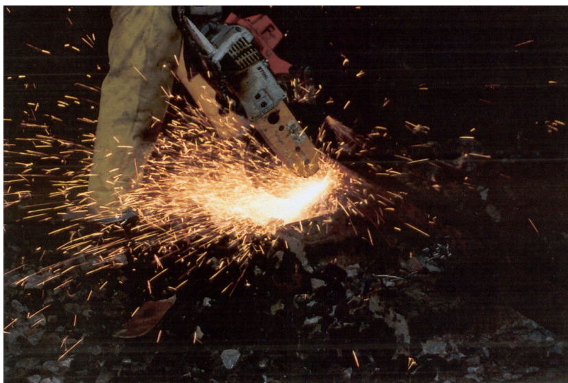
Figura 3 – Operação de corte de carril.
