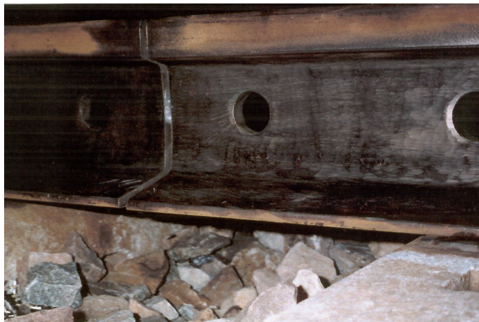
Figura 6 – Carril cortado, furado e rebarbado.
