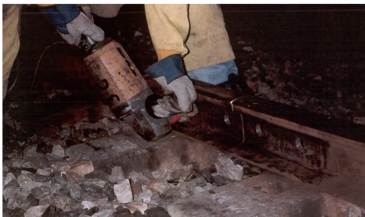
Figura 5 – Operação de limpeza do carril.
