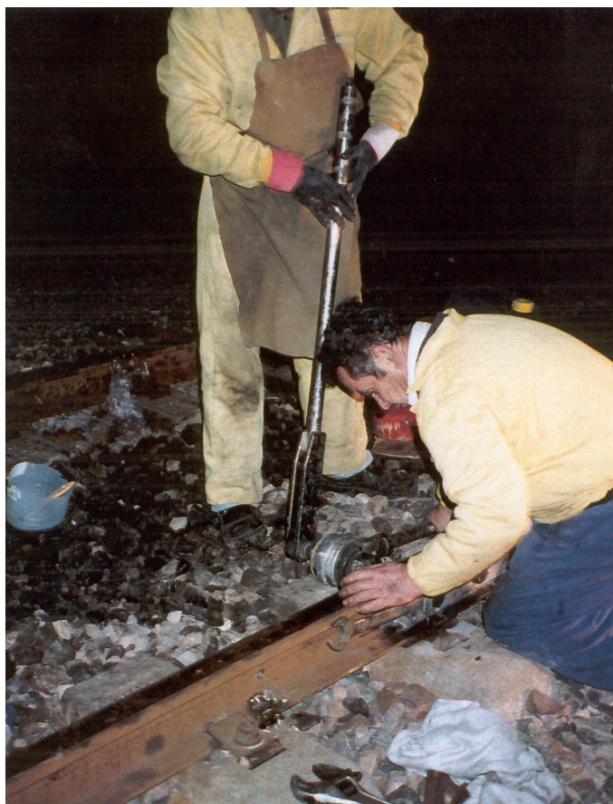
Figura 12 – Operação de aperto da fixação.
